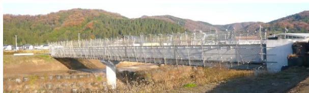
天王川改修七房歩道橋桁再架設R07.11
